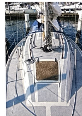
Das Vorluk besteht aus einem GfK-Deckel mit klarem Gelcoat, häufig ist die Dichtung verschlissen.
